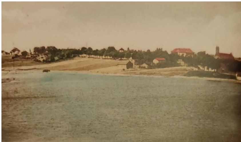
Fot. 1. Poczтівка przedstawiająca brzeg jeziora Dąbrowa Mała, po prawej stronie, poniżej budynku kościoła widoczne dawne grodzisko. Fotografia wykonana najprawdopodobniej przed 1902 r. ponieważ nie ma jeszcze przy brzegu wypożyczalni sprzętów wodnych (za W. Mierzwa, 2021, s. 46).
