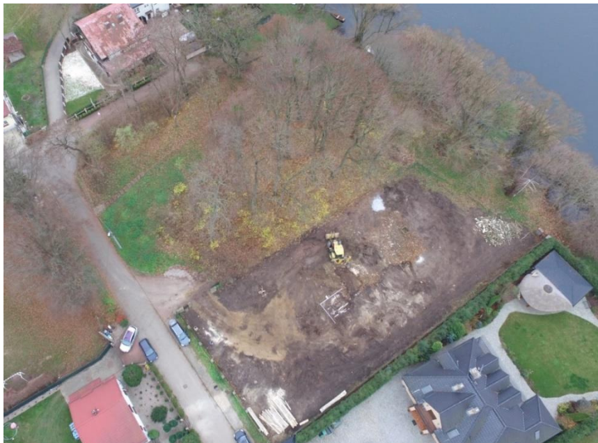
Fot. 7. Widok z drona na dz. ew. nr 605/2 po odhumusowaniu terenu i odkryciu pozostałości dawnej oczyszczalni ścieków.
