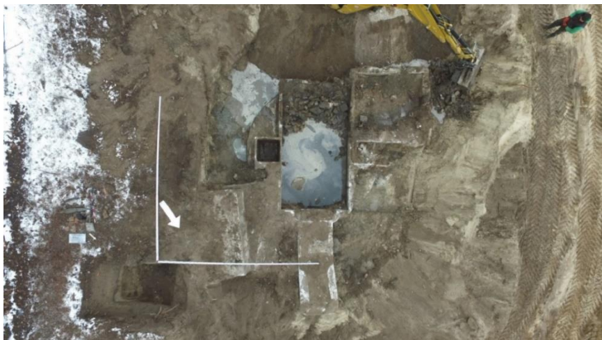
Fot. 9. Rzut z drona na rozbiórkę dawnej oczyszczalni ścieków.
